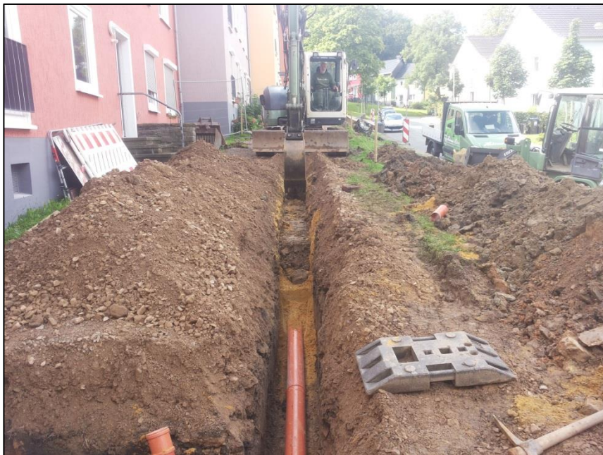
Neu angelegter Kanal auf dem Gelände von en|wohnen in der Breslauer Straße
